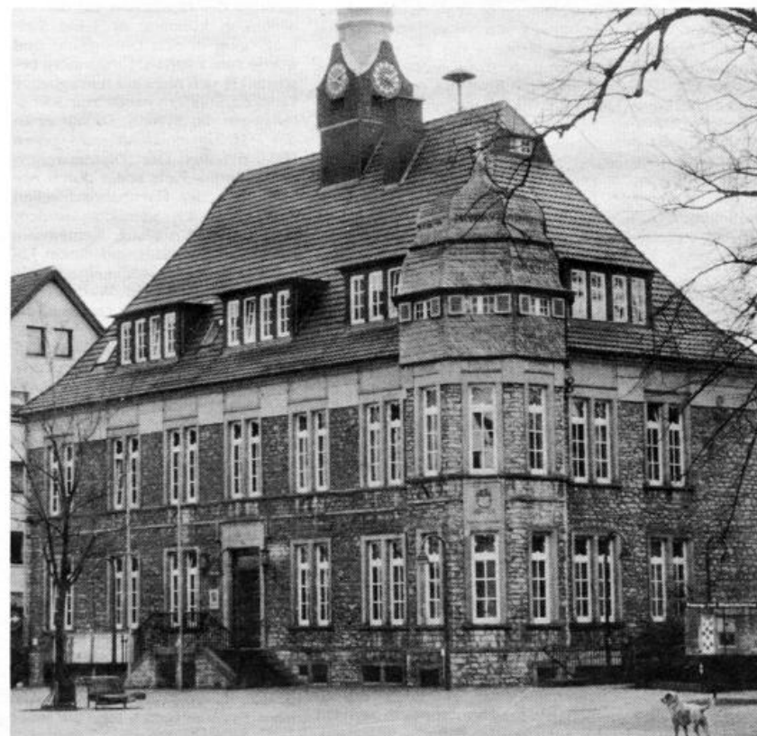
Meßmann macht's möglich: Das Lagenser Rathaus erhält mehr Raum, in dem es etwas aufs Dach bekommt. 1904 wurde an Stelle des bestehenden flachen Daches ein steiler Dachstuhl aufgesetzt und als Geschoss ausgebaut.
