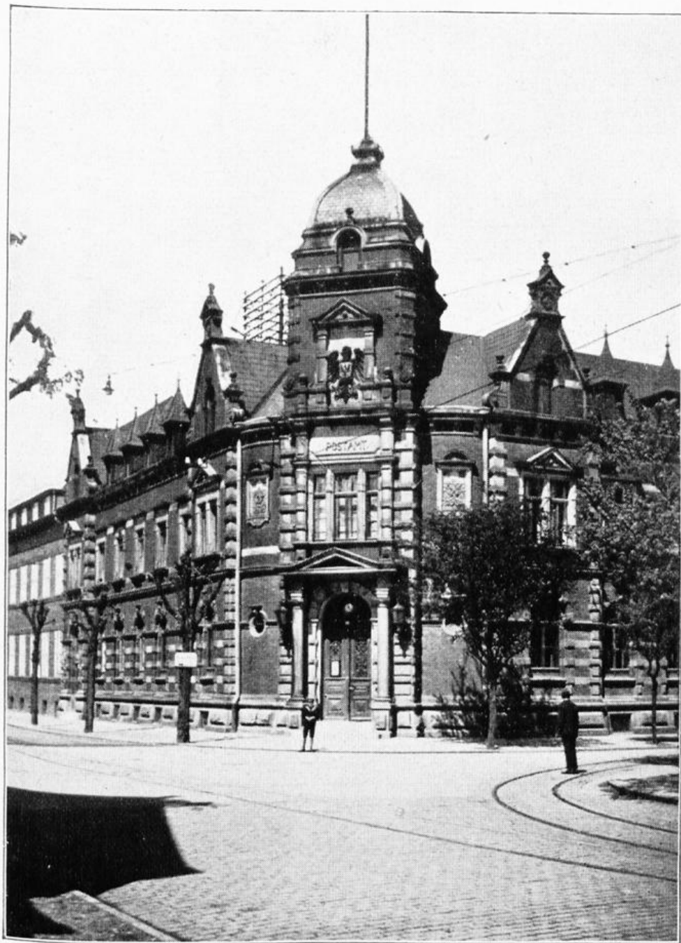
Postamt Detmold (seit 1890, mit Erweiterungsbau seit 1927) (zu Seite 150)
