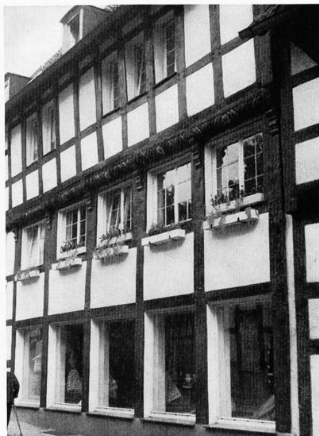
Abb. 56: Vorbildliche Schaufenster unter Erhaltung des tragenden Fachwerkgefüges von 1672. (Halle/Westf., Architekt: Landesbaupfleger Brunne)
