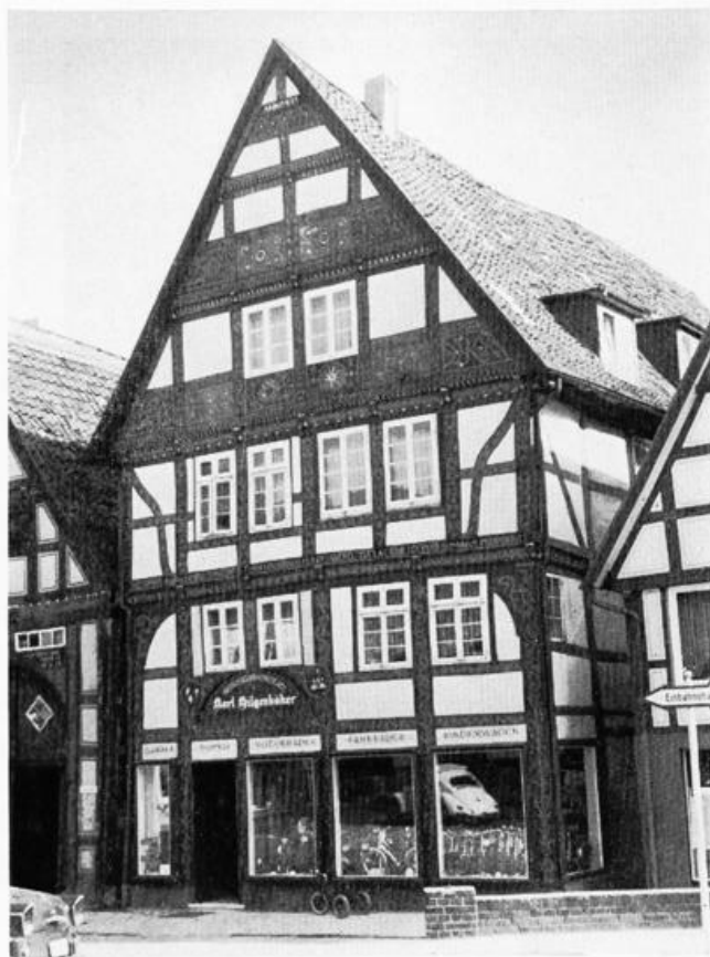
Abb. 55: Schaufenstereinbau unter Erhaltung des tragenden Fachwerkes von 1621. Das Haus „steht“ noch. Geschickte Anbringung der Beschriftung (Bad Salzungen/Lippe, Architekt H. Loos)
