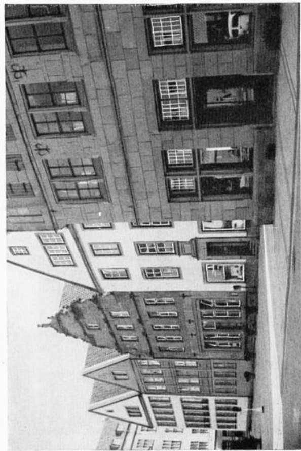
Abb. 57: Hinter massiver Fassade (rechts) Passage mit voll verglaster Auslage. Linke Bildhälfte: Ein alter und drei neue Giebel bilden gemeinsam mit dem gotischen Giebel des Crüwellhauses (rechts) eine geschlossene Baugruppe. Die beiden unteren Geschosse des Crüwellhauses sind zweimal umgebaut, der Giebel darüber ist original (Bielefeld)
