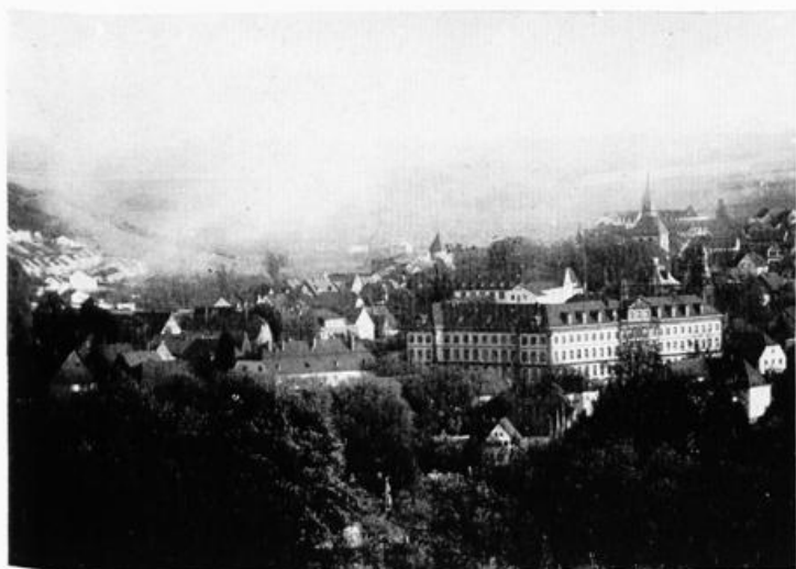
Abb. 29: Die gesamte Stadtsituation beherrschendes Baudenkmal zwingt zu entscheidenden, entsprechenden Konsequenzen in der Stadterneuerung (Büren/Westf.). Der Qualm entstammt drei Fabrikschornsteinen, die seit Jahrzehnten ihren Schmutz auf Bürger und Baudenkmale herabrieseln, weil sie als erhebliche Gewerbesteuerzahler noch nicht längst auf abgelegene Gebiete verwiesen wurden.
