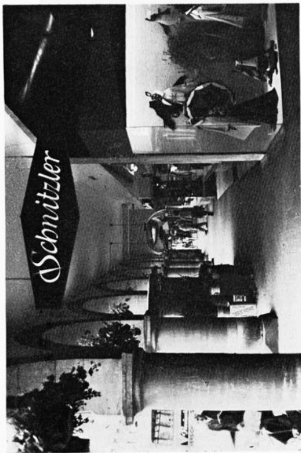
Abb. 58: Hinter den massiven, wuchtigen Arkadenbögen Vollverglasung von Boden bis Decke: Eine gute Möglichkeit, bei bis zum Straßenniveau einheitlich gestalteter Hausfront modernste Schaufenster anzulegen (Münster, Prinzipalmarkt, s. auch Abb. 81)
