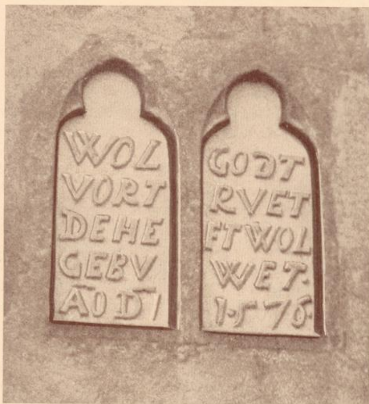
Inschrift im obersten Giebelfeld des Geschäftshauses.
